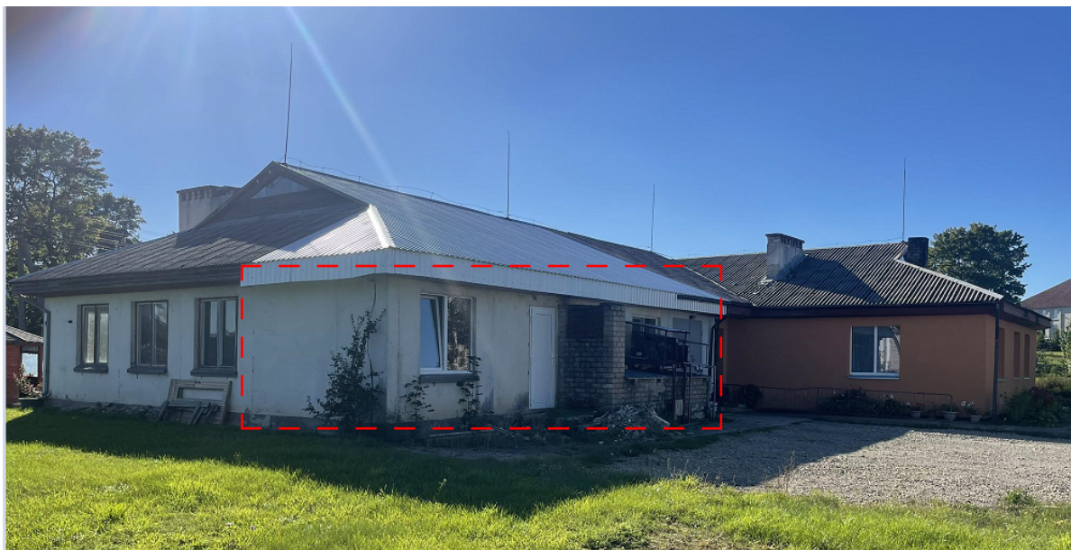
Pastato šiaurinis fasadas
