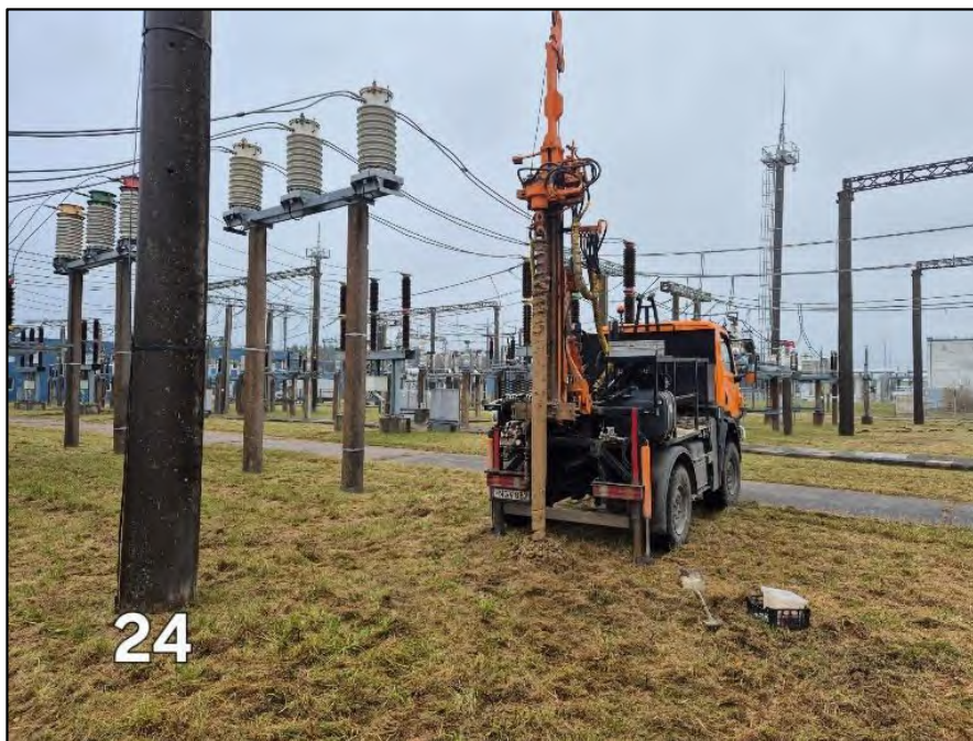
Pav. 1 Gręžimo įranga H-25 tyrimų taške Gr.SZ-24 vietoje (aut. T. M )
