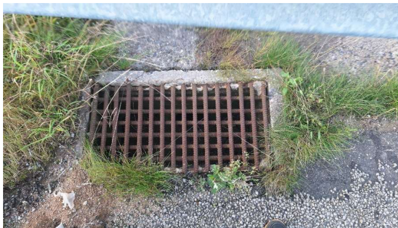
6 pav. Įdubę, nusidėvėję vandens nuvedimo šulinėliai tilto prieigose.
