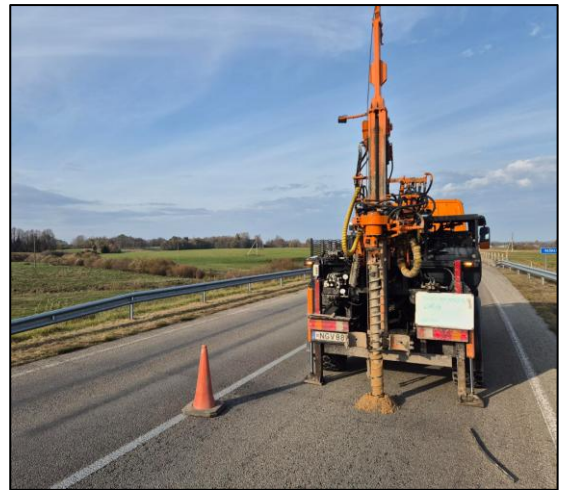
Pav. 1 Gręžimo agregatas H-25SR tyrimų vietose: kairėje Gr.1, dešinėje Gr.4 (aut. T. Mačiulis).
