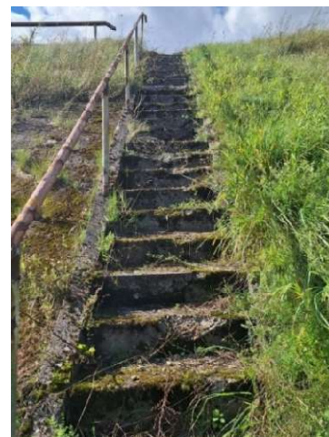
10 pav. Įrengtas pagalbinis išramstymas, pažeistas šlaito tvirtinimas (trūksta vieno iš atraminių vamzdžių), korozijos pažeisti šlaitinių laiptų turėklai, pakopos apaugusios žolėmis
