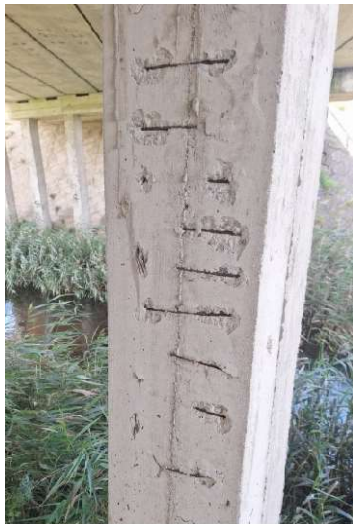
9 pav. Taurų konstrukcijos ištrupėjimas, armatūra be apsauginio sluoksnio.
