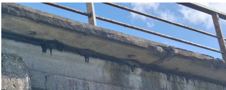
7 pav. Ištrupėję šalitilčio plokštės kraštai, nusidėvėjusi betono danga. Turėklai pažeisti korozijos.
