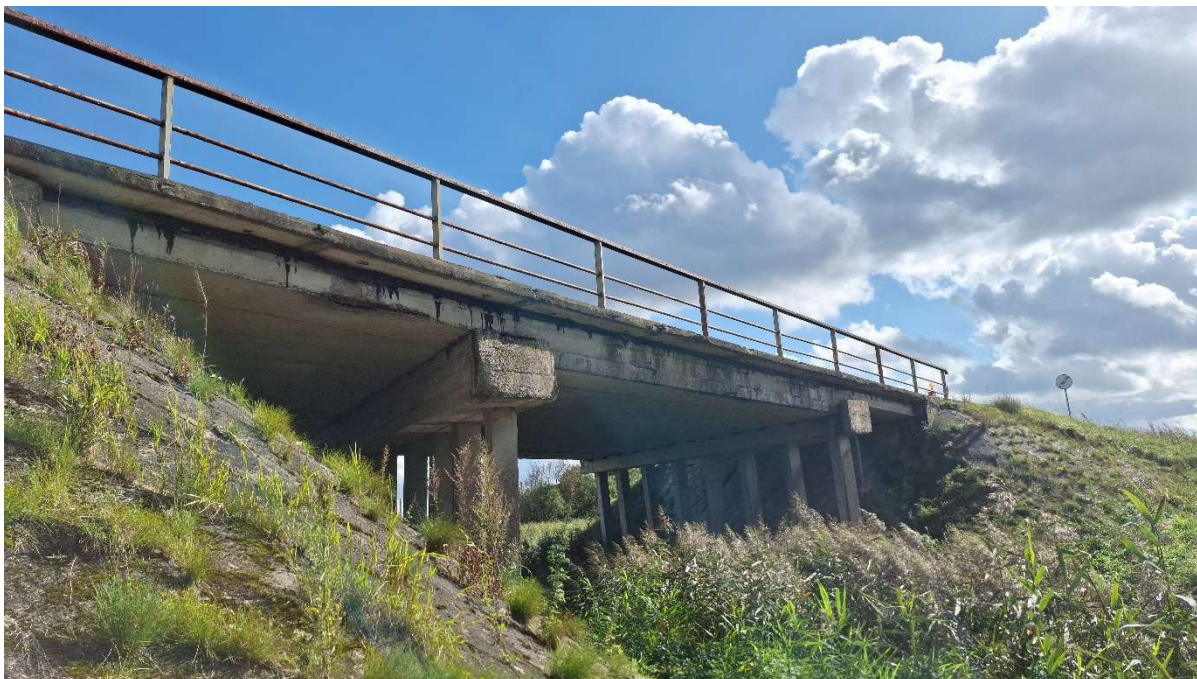
3 pav. Tilto vaizdas iš žemupio pusės
