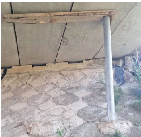
10 pav. Įrengtas pagalbinis išramstymas, pažeistas šlaito tvirtinimas (trūksta vieno iš atraminių vamzdžių), korozijos pažeisti šlaitinių laiptų turėklai, pakopos apaugusios žolėmis
