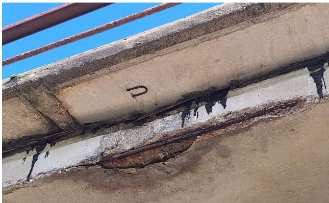
5 pav. Iš betono išplauti kalcio karbonatai. Betonas ištrupėjęs, koroduoja armatūra.
