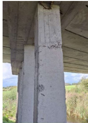
9 pav. Taurų konstrukcijos ištrupėjimas, armatūra be apsauginio sluoksnio.
