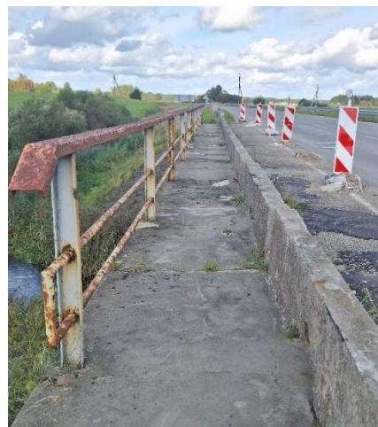
7 pav. Ištrupėję šalitilčio plokštės kraštai, nusidėvėjusi betono danga. Turėklai pažeisti korozijos.
