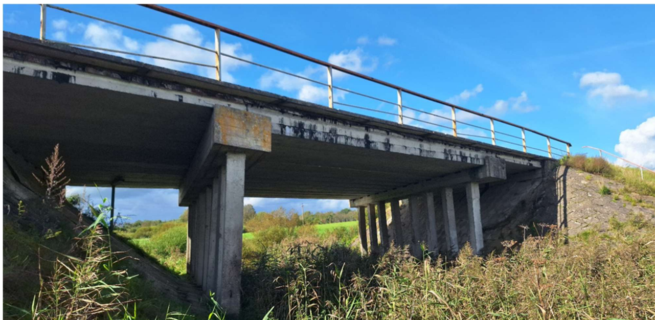
2 pav. Tiltlo vaizdas iš aukštupio pusės
